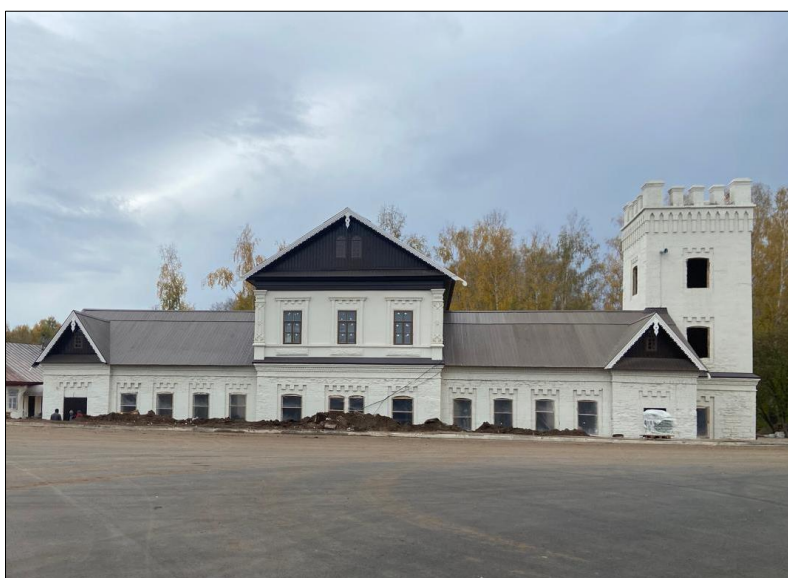
Здание Краеведческого музея Менделеевска (заводской конторы Бондюжского завода) в ходе реставрационных работ, 2025 г.
